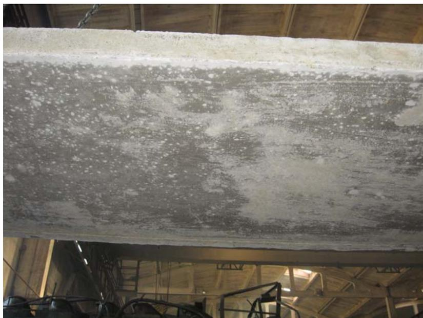
Рисунок 5 – Образец поверхности бетонной плиты после применения в качестве смазки для разборной опалубки эмульсии на основе масла ВД-3, жирной кислоты и неолола. Концентрат эмульсола подвергнут ультразвуковой обработке по разработанной методике
